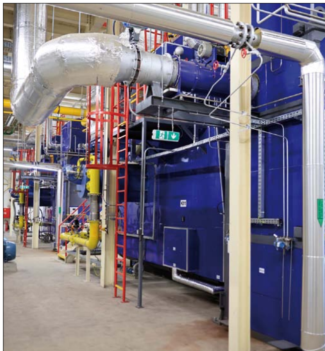
Obr. 1. Nové plynové kotle v českomeziříčském cukrovaru
