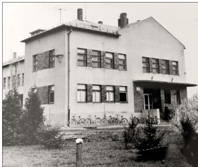
Obr. 2. Bývalá hlavná budova ŠS, vybudovaná v roku 1957
