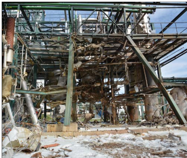
Obr. 2. Dobrovický lihovar poškozený explozí (22. 9. 2015)
