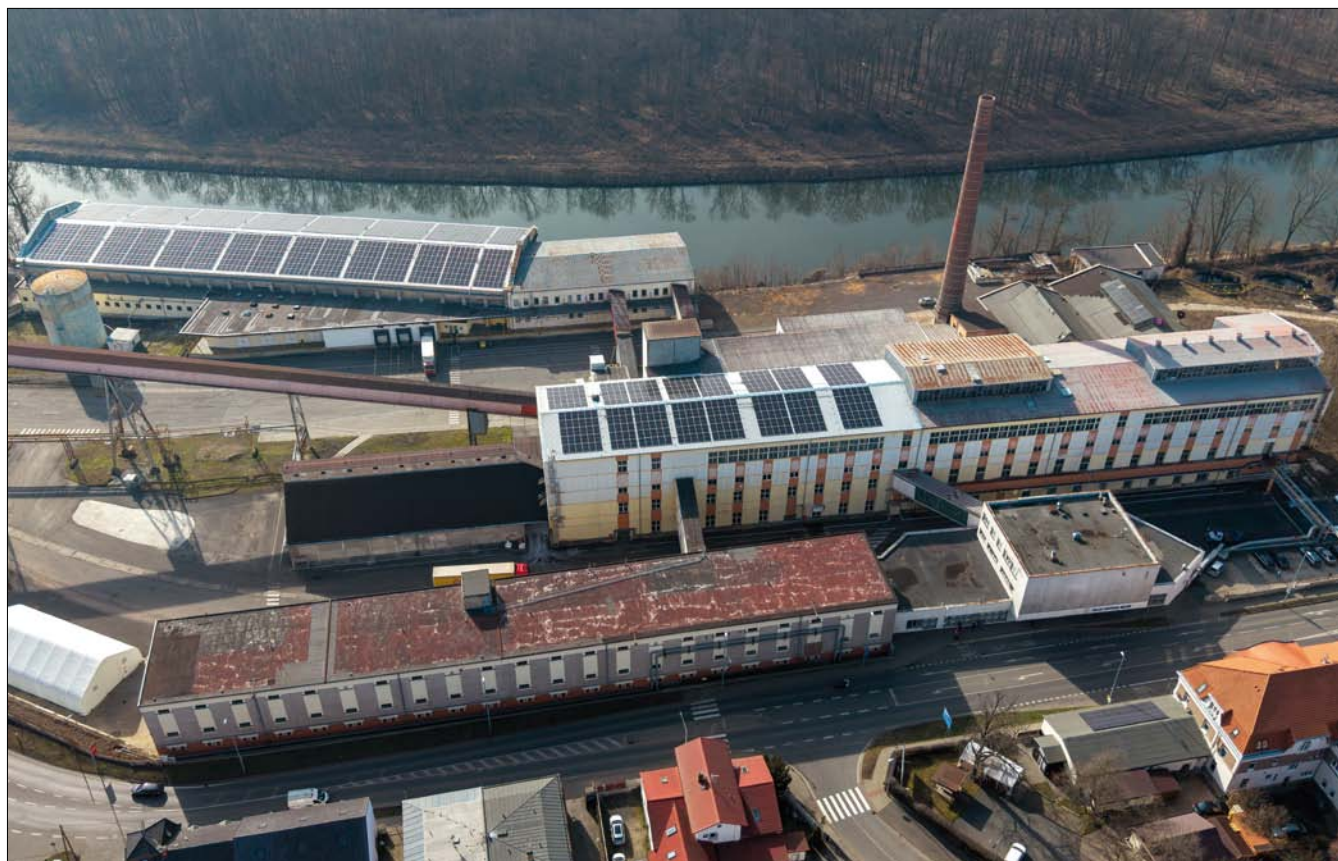
Obr. 3. V balicím centru Tereos TTD v Mělníku byla loni uvedena do provozu fotovoltaická elektrárna na střechách objektů
