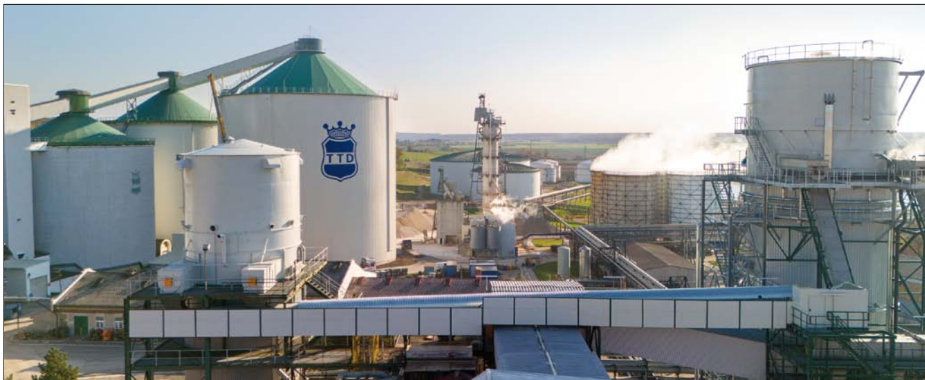
Obr. 1. Cukrovar Dobruška v posledních letech zásadně modernizoval (pračka řepy, věžová extrakce, nové skladovací silo na cukr)
