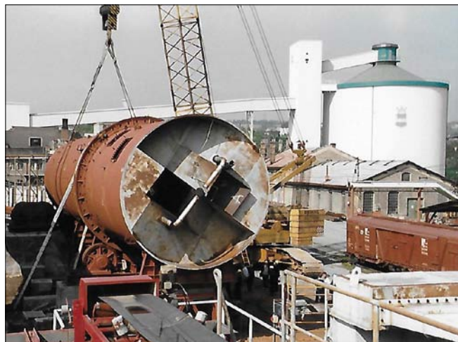
Obr. 7. Montáž bubnového extraktoru RT
