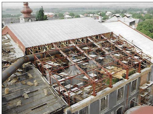
Obr. 8. Z rekonstrukce varny, nové zrněče
