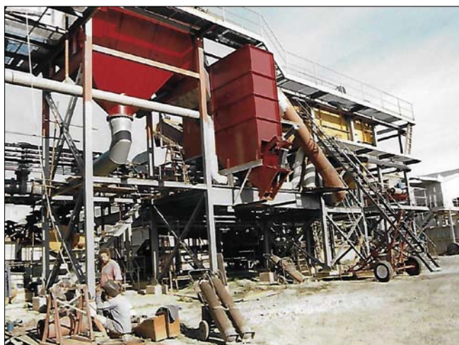
Obr. 4. Budování prací linky v dobrovickém cukrovaru (1993)
