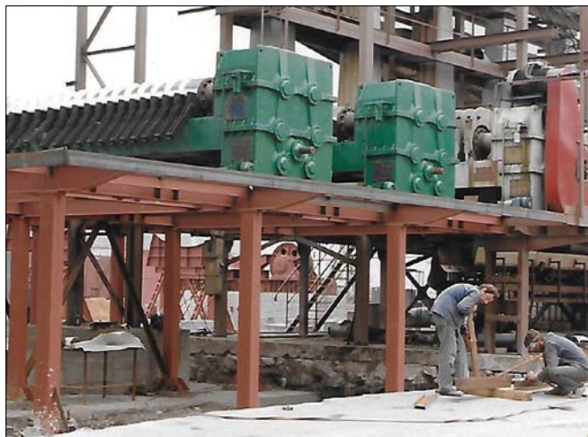
Obr. 5. Montáž řízkolisů (1993)
