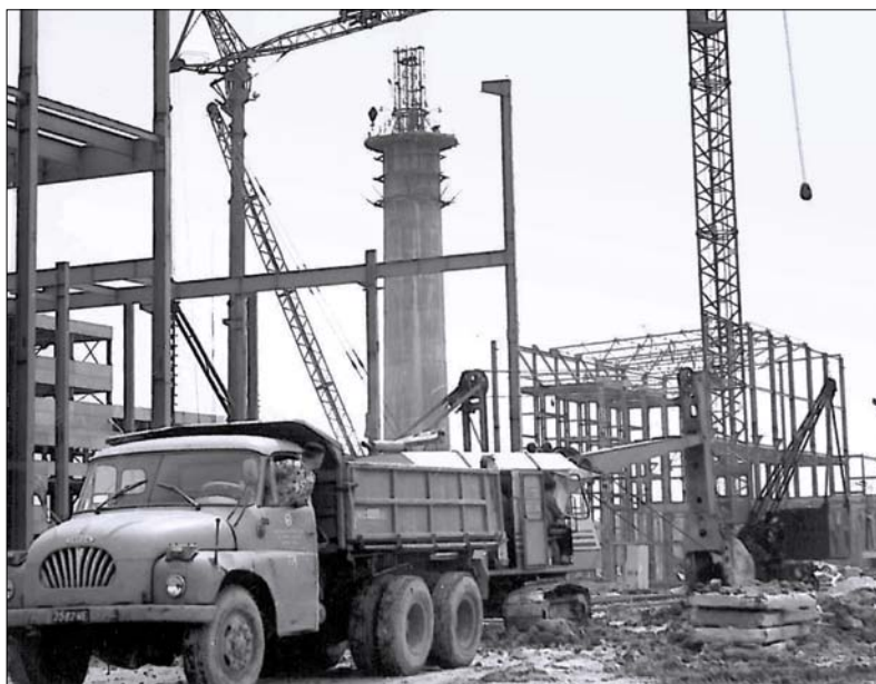
Obr. 4. Z výstavby nového závodu (stavba komínu)
