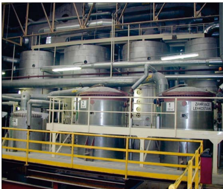
Obr. 8. Zahříváče lehké šťávy před odparkou
