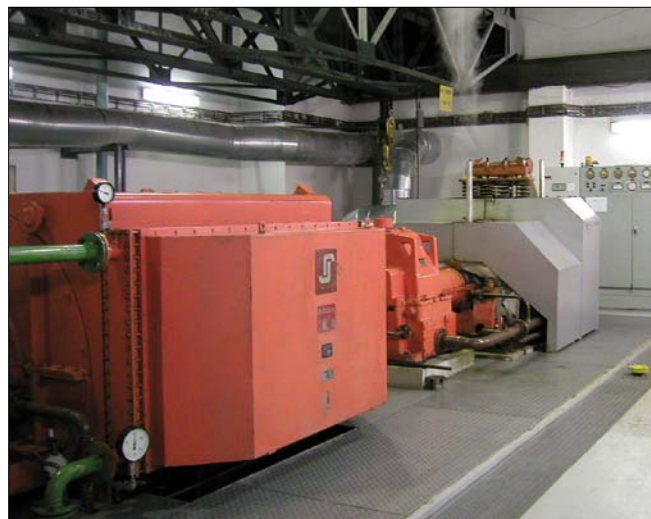
Obr. 4. Tepelně energetická centrála: turbogenerátor (3)
