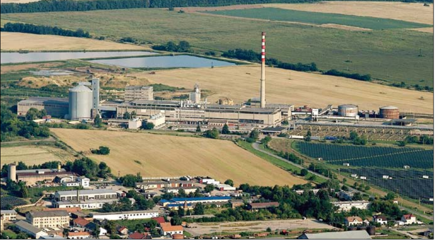
Cukrovar v Hrušovanech nad Jevišovkou
