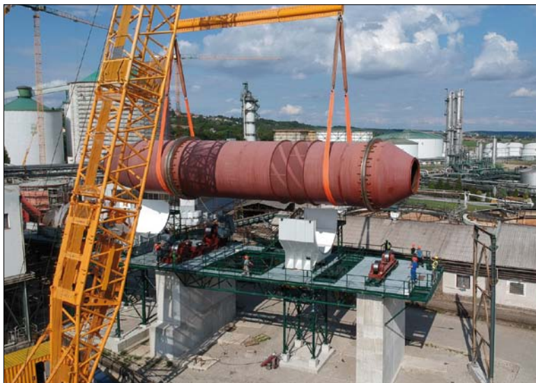
Obr. 2. Usazování bubnu pračky řepy
