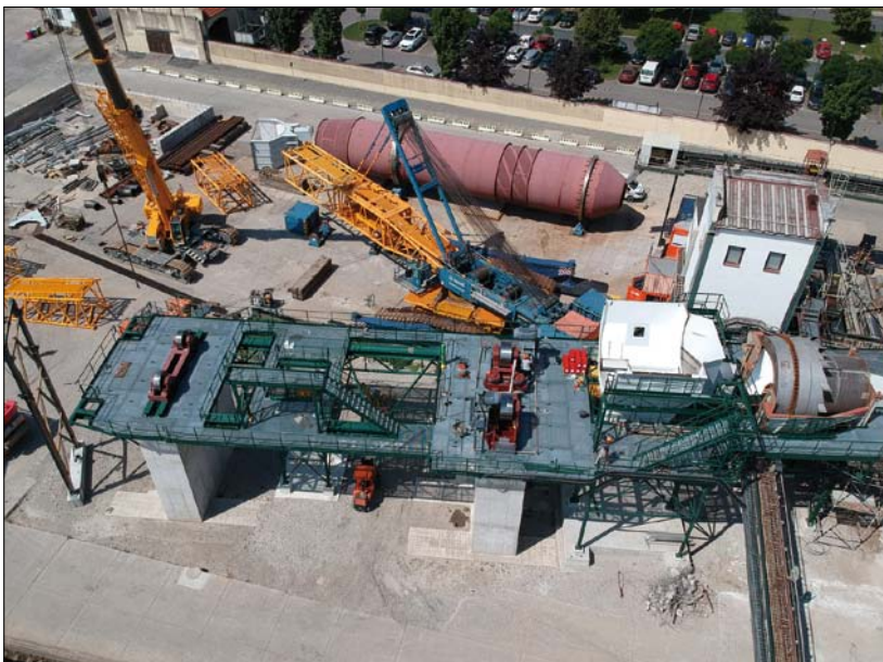
Obr. 1. Příprava na usazení nové bubnové pračky Maguin
