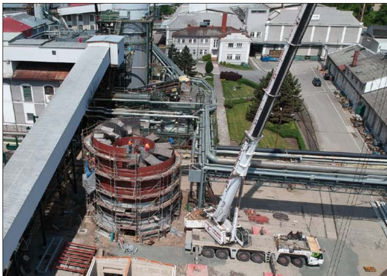
Obr. 3. Extraktor BMA – postupná instalace jednotlivých prstenců zařízení
