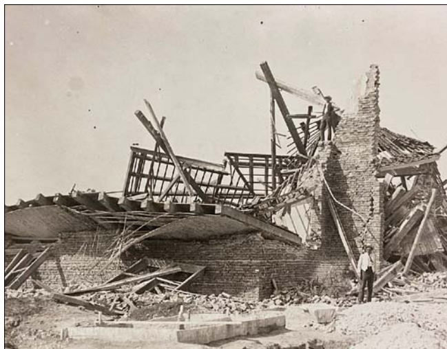
Obr. 2. Zemětřesením poškozené obytné budovy (obr. VII. a XII.)
