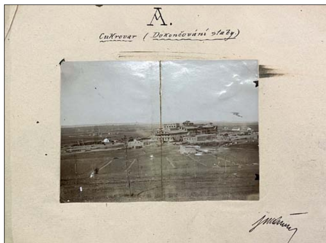
Obr. 1. Část „A“ Cukrovar (dokončování stavby)
