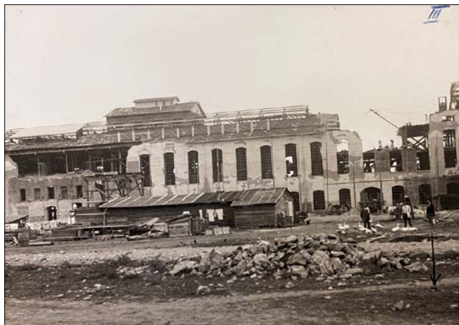
Obr. 2. Cukrovar poškozený zemětřesením (obr. III., IV., V. a VI.)
