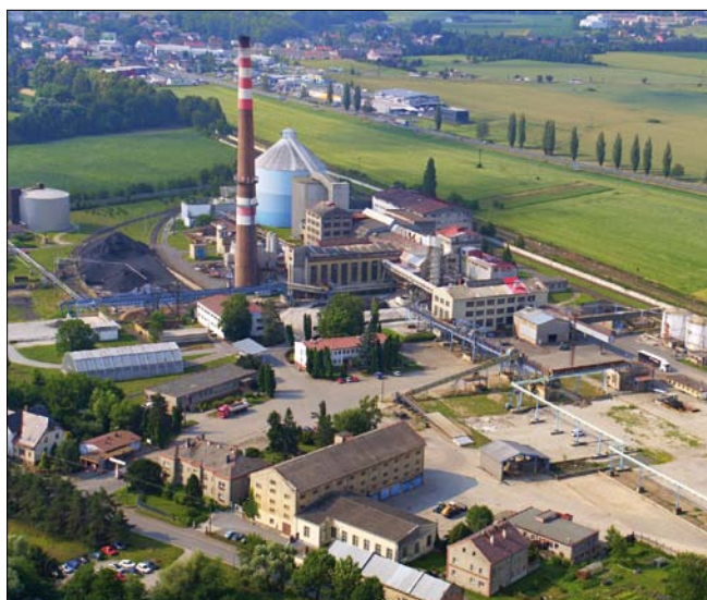
Obr. 7. Celkový pohled na cukrovar v současnosti (2022)
