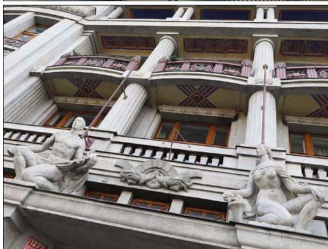
Budovy bývalé Průmyslové tiskárny (nahoře), bytové domy v ulici Nad štolou č. 8 a 7 (uprostřed), detail průčelí domu č. 7 (dole)
