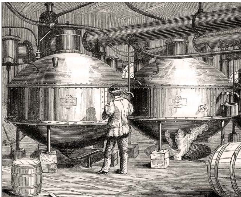
Vakua v cukrovaru (pramen: Das neue Buch der Erfindungen, Gewerbe und Industrien , 1878)
