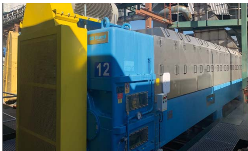
Obr. 4. Tereos TTD: OP P I K – Výměna řízkolisů č. 12 v cukrovaru Dobrovice
