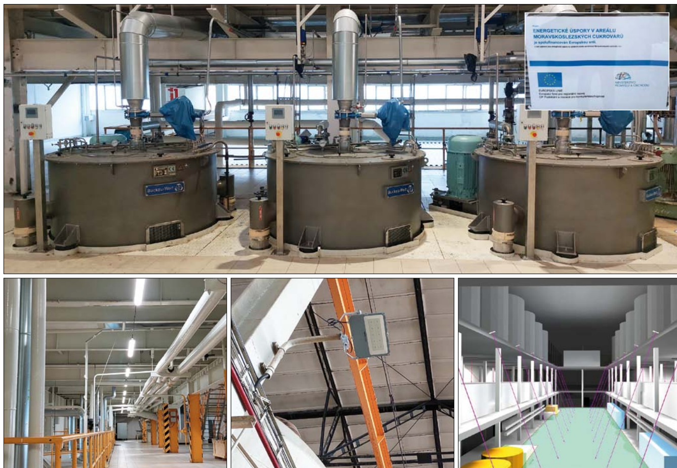
Obr. 5. Z hrušovanského cukrovaru: nové odstředivky (nahore) a nové osvětlení hlavní výrobní budovy (dolní obrázky) v rámci projektu OPPIK – Energetické úspory v areálu Moravskoslezských cukrovarů, s. r. o.
