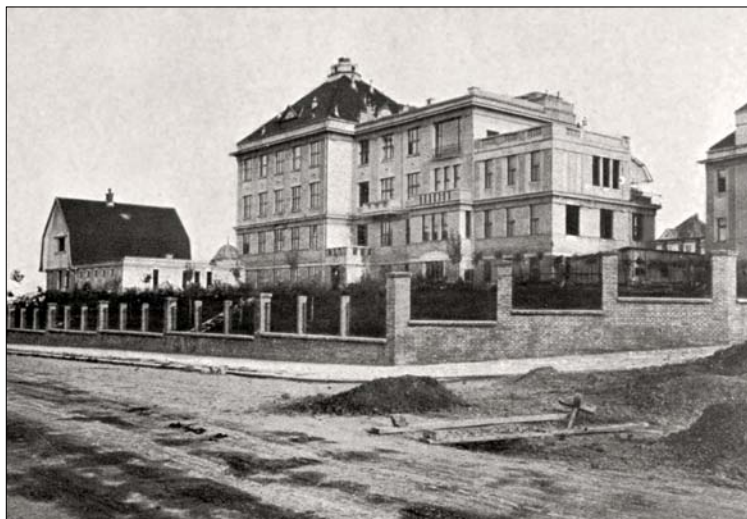
Obr. 4. Pohled na výzkumný ústav od severozápadu (1923)
