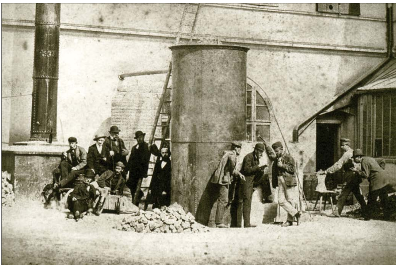
První pokusy s Frey-Jelínkovou saturací v cukrovaru v Praze-Vysočanech v květnu 1863. V pozadí malá koksová vápenka sloužící k pokusům v malém, v popředí pec použitá ke zkouškám ve velkém. Na fotografii zleva: Čeněk Daněk, majitel strojírní v Praze; K. Mikula, cukřmistr ve Slatiňanech; Bedřich Frey starší, majitel cukrovaru Vysočany; cukřmistr Rabe, Vysočany; Bedřich Frey mladší, Vysočany; Ferdinand Urbánek, majitel cukrovaru v Modřanech; dr. Karel Augustin Weiler, spolkový chemik; Karel Frey, Vysočany; Hugo Jelínek, správce cukrovaru Vysočany; Schaller, adjunkt v cukrovaru Vysočany; dělník obsluhující pec; Šalomoun Huber, majitel strojírní v Karlíně.
