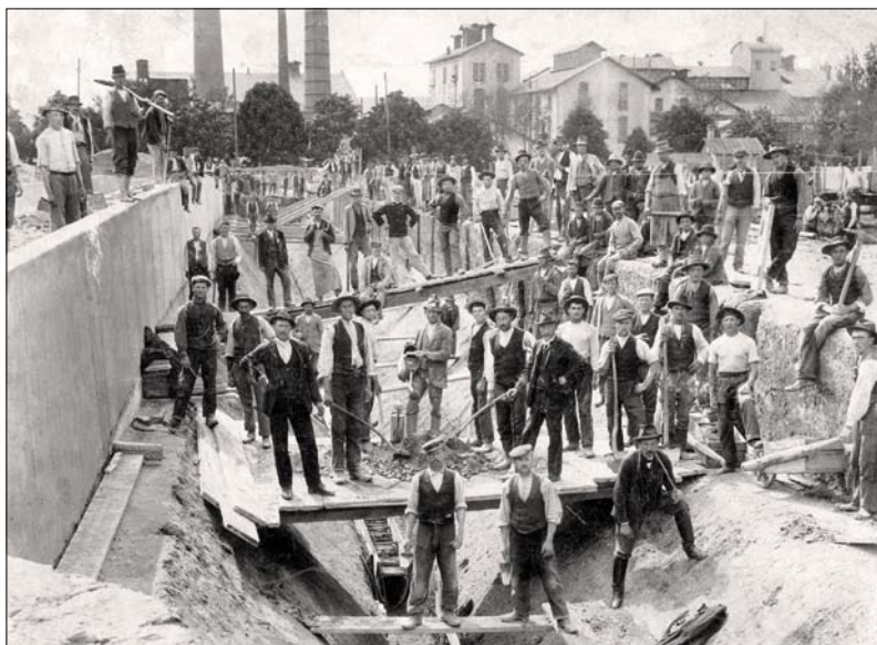
Obr. 3. Stavba řepných kanálů (přibližně koncem 19. století)
