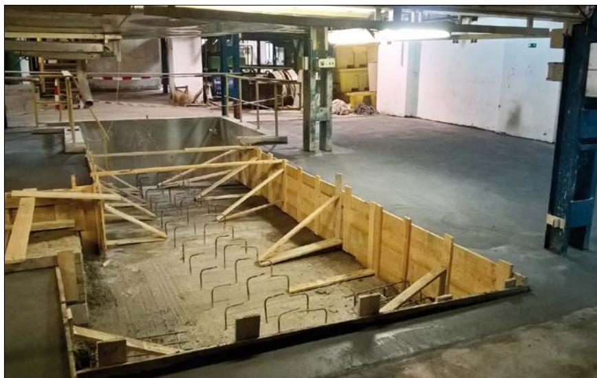
Obr. 4. Příprava základů pro dopravníky mokrého cukru
