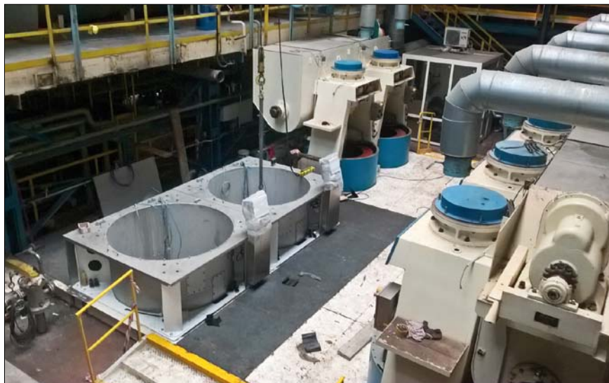
Obr. 3. Montáž jednotlivých dílů odstředivek na upravenou ocelovou konstrukci
