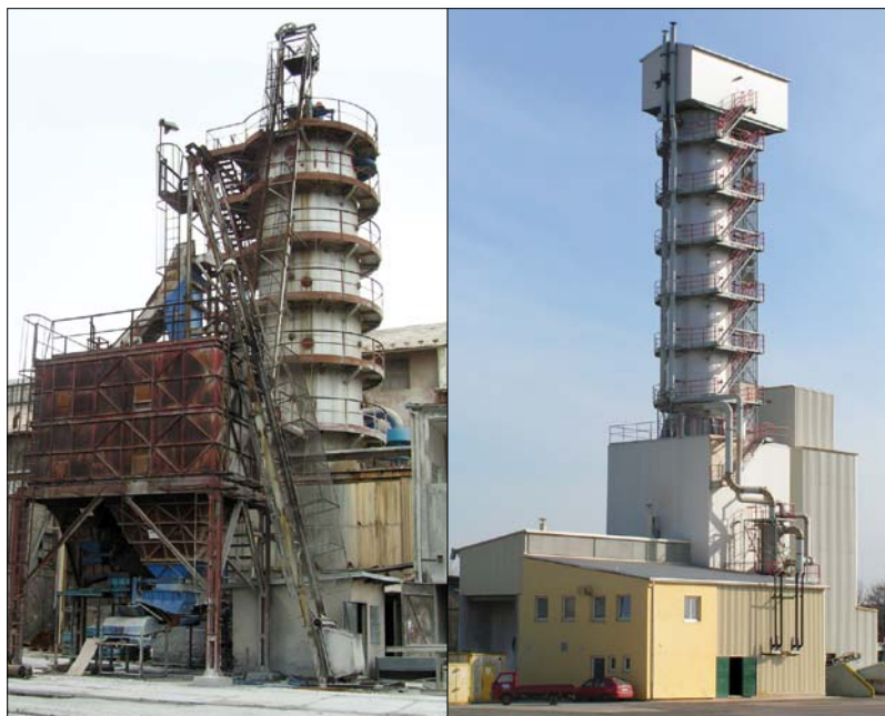
Vápenka – vápenka typu Khern (vlevo) a vápenka s válcovou šachtou
