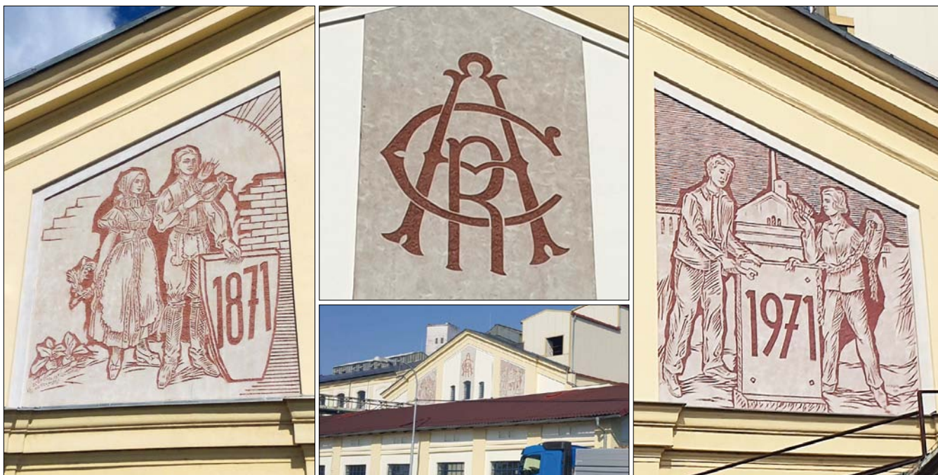
Obr. 4. Z průčelí výrobní budovy litovelského cukrovaru
