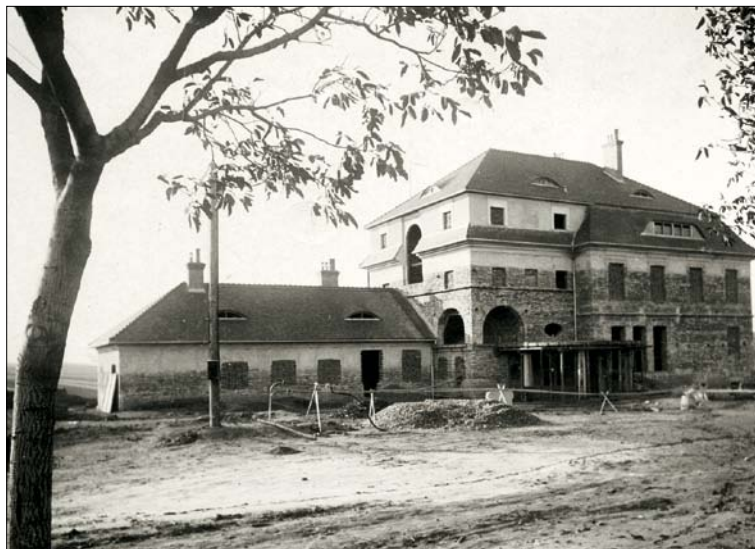
Obr. 2. Ždánice – hrubá stavba tzv. Seidlovy vily v roce 1907
