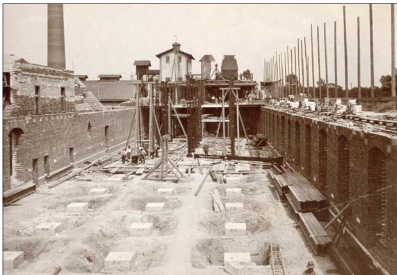
Obr. 1. Stavba rafinerie v mělnickém cukrovaru (1913)
