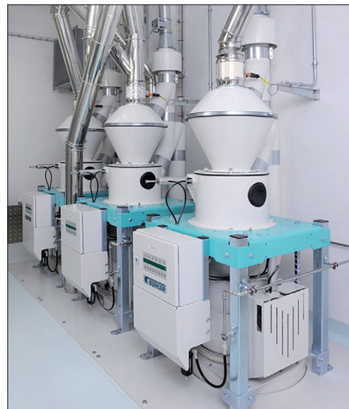
Obr. 7. Automatická zásobníková váha MSDL Bühler ( www.buhlergroup.com )
