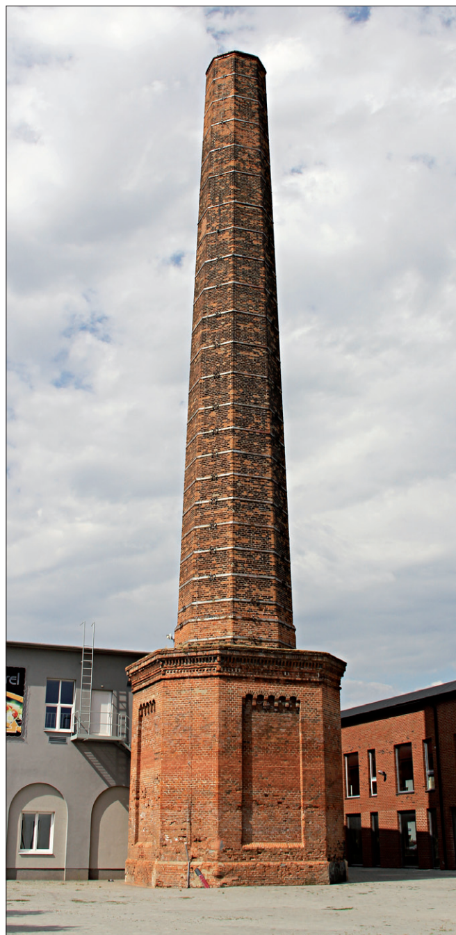
obr. 2. Židlochovice – památkově chráněné komínové těleso bývalé sušárny řízků
