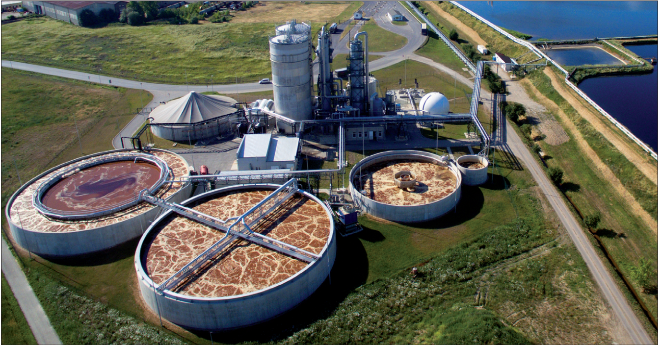
Obr. 3. Čistírna biostanice na zpracování výpalků z lihovaru Dobrovice
