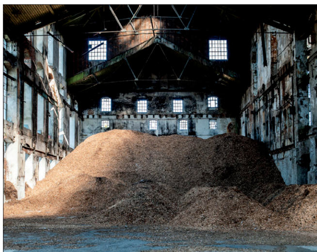
Obr. 4. Pohľad do útrob zničenej budovy cukrovary Šurany
