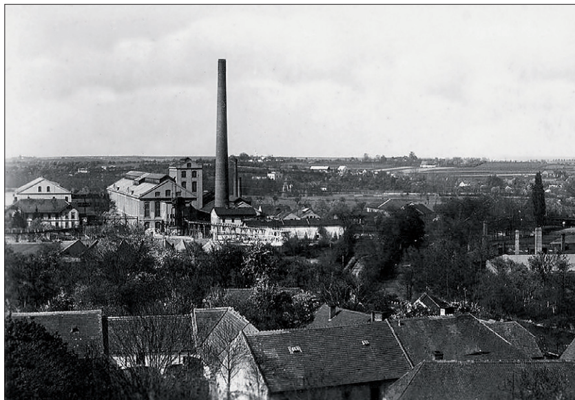
Obr. 6. Pohled na cukrovar od jihozápadu: lze upozornit na Khernovu vápenku 40 m 3 vlevo od komína, dopravník na řízky i visutou dráhu na kaly; dobře patrná je i dvojice krytých ocelových mostů pod sebou, spojující hlavní budovu se skladem rafinády
