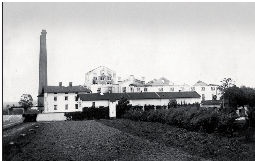
Obr. 2. Budovy původního cukrovaru po požáru v srpnu 1915, pohled od jihu
