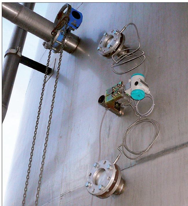
Obr. 2. Hydrostatické měření hustoty v zásobníku v lihovaru Dobrovice, Tereos TTD, a. s. (foto M. Kmínek)
