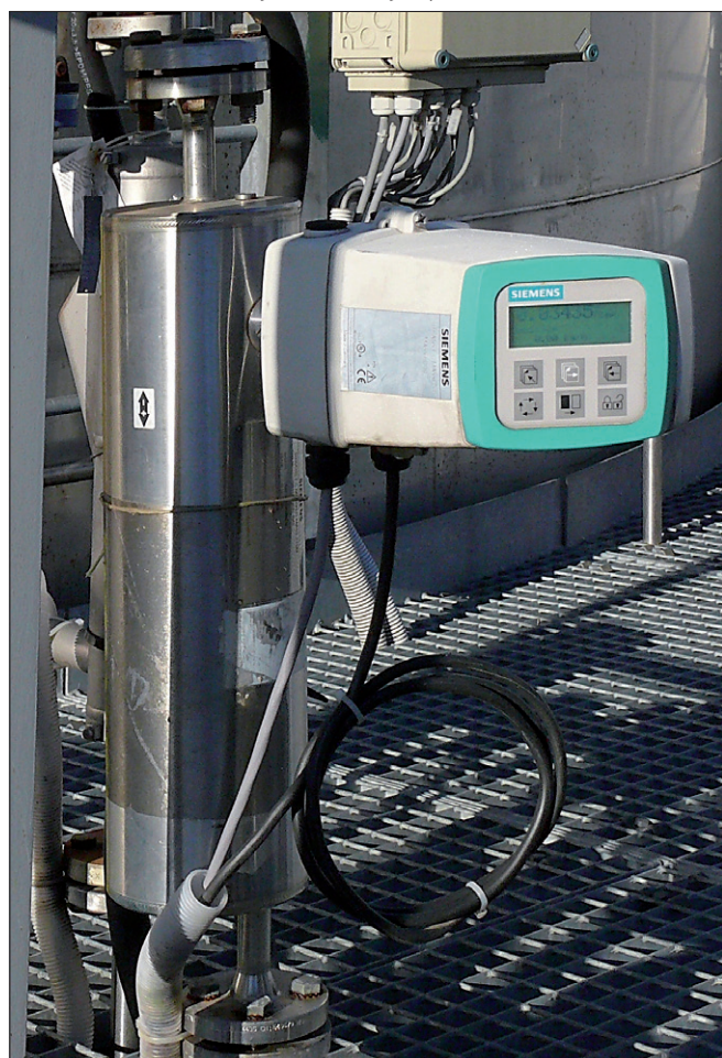
Obr. 10. Měření hustoty Coriolisovým průtokoměrem
