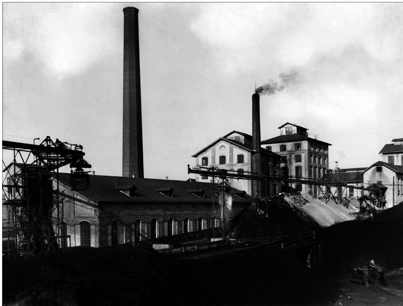
Obr. 6. Pohled na modřanský cukrovar od jihu, v popředí kotelná s ukládkou paliva a kolejíštěm vlečky, komíny, drahami pro dopravu popela (vlevo) a saturačních kalů (vpravo), s výrobními budovami v pozadí – nedatovaná fotografie zachycuje stav velmi blízký Maštalkově modelu, pořízena byla přibližně o dekádu dříve
