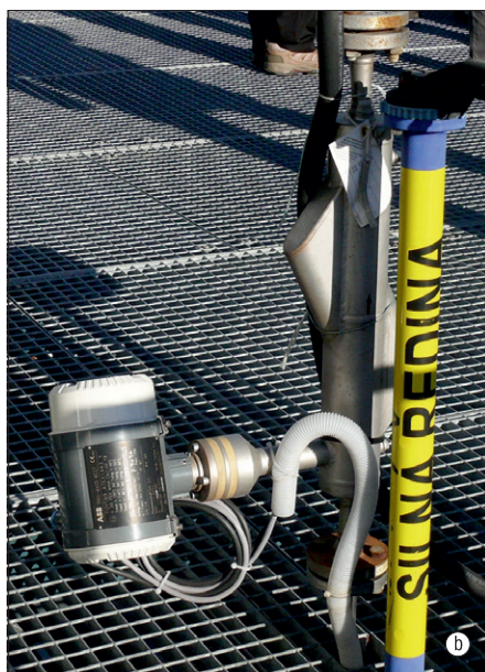
Obr. 5. Příklady instalací Coriolisových průtokoměrů v průmyslových provozech: a) průtokoměr Siemens Sitrans (www.siemens.cz) – lihovar Dobrovice, Tereos TTD, a. s.; b) průtokoměr ABB TRIO-MASS (www.abb.cz/mar) – průtok řediny v lihovaru Dobrovice, Tereos TTD, a. s., (foto M. Kmínek); c) průtokoměr Krohne Optimass (www.krohne.cz) – průtok kakaového másla v závodě Zora Olomouc (foto Nestlé)
