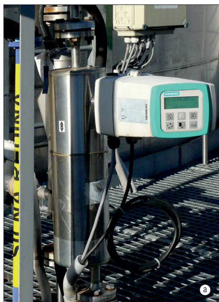
Obr. 5. Příklady instalací Coriolisových průtokoměrů v průmyslových provozech: a) průtokoměr Siemens Sitrans (www.siemens.cz) – lihovar Dobrovice, Tereos TTD, a. s.; b) průtokoměr ABB TRIO-MASS (www.abb.cz/mar) – průtok řediny v lihovaru Dobrovice, Tereos TTD, a. s., (foto M. Kmínek); c) průtokoměr Krohne Optimass (www.krohne.cz) – průtok kakaového másla v závodě Zora Olomouc (foto Nestlé)
