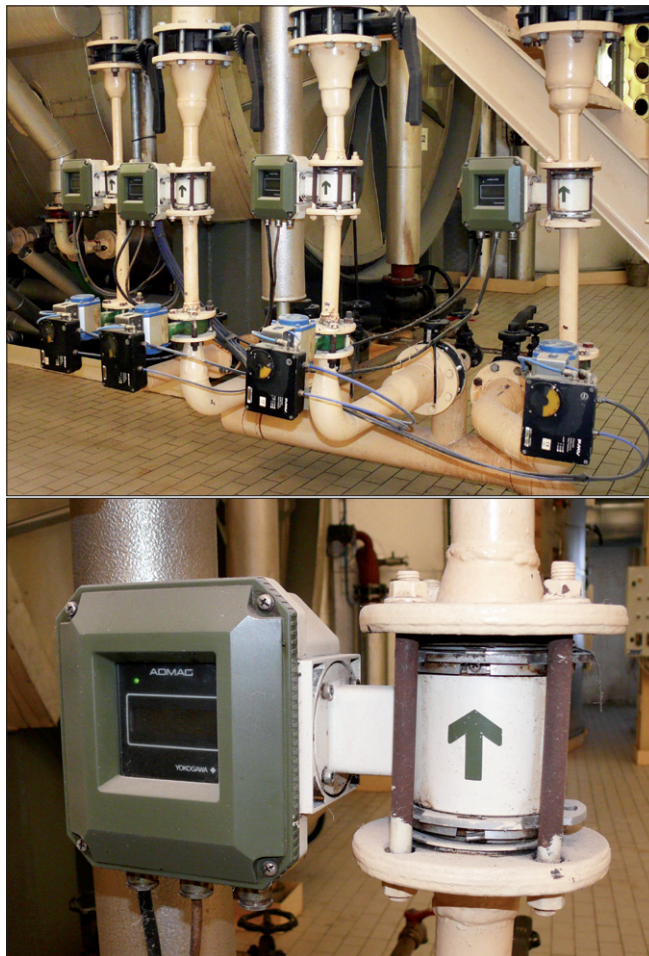
Obr. 6. Indukční průtokoměry Yokogawa – Admag ve varně cukrovaru Dobrovice Tereos TTD, a. s. (foto M. Kmínek)
