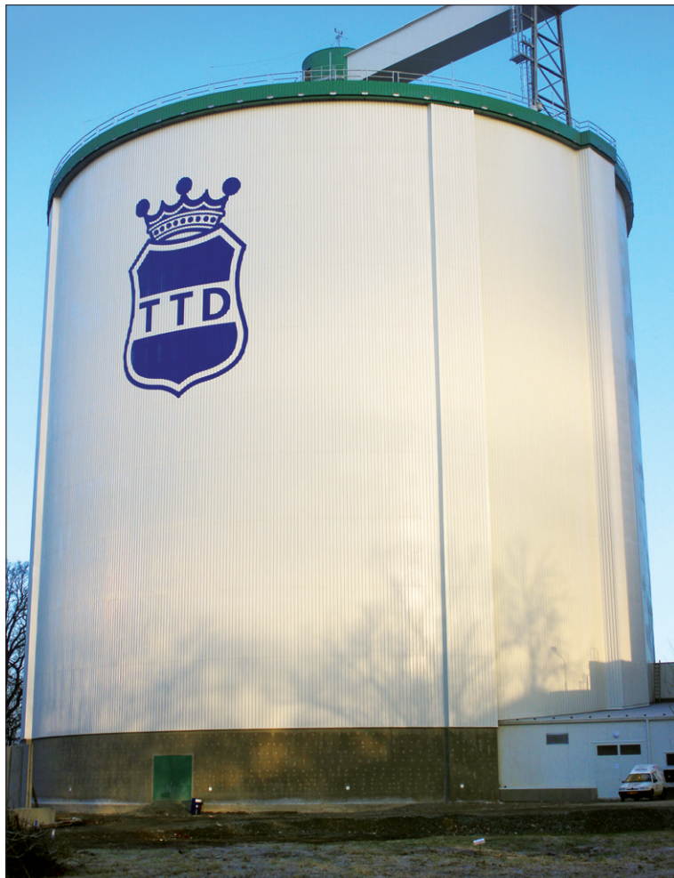
Obr. 5. Jedna z největších investic posledních let v cukrovaru České Meziříčí: silo na 50 000 tun cukru
