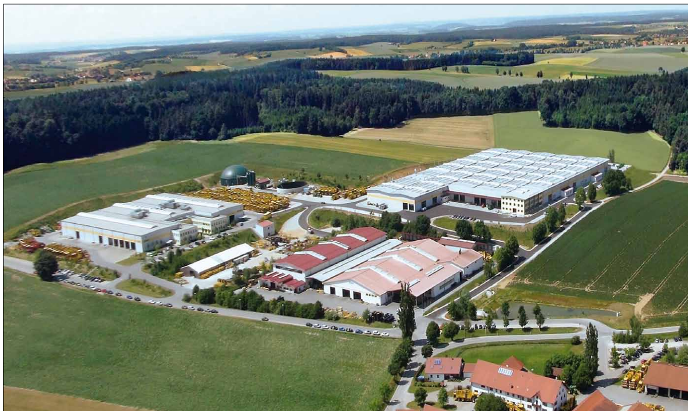
Obr. 1. Letecký pohled na areál společnosti ROPA v bavorském Sittelsdorfu s novými výrobními halami vpravo vzadu (foto Ropa)
