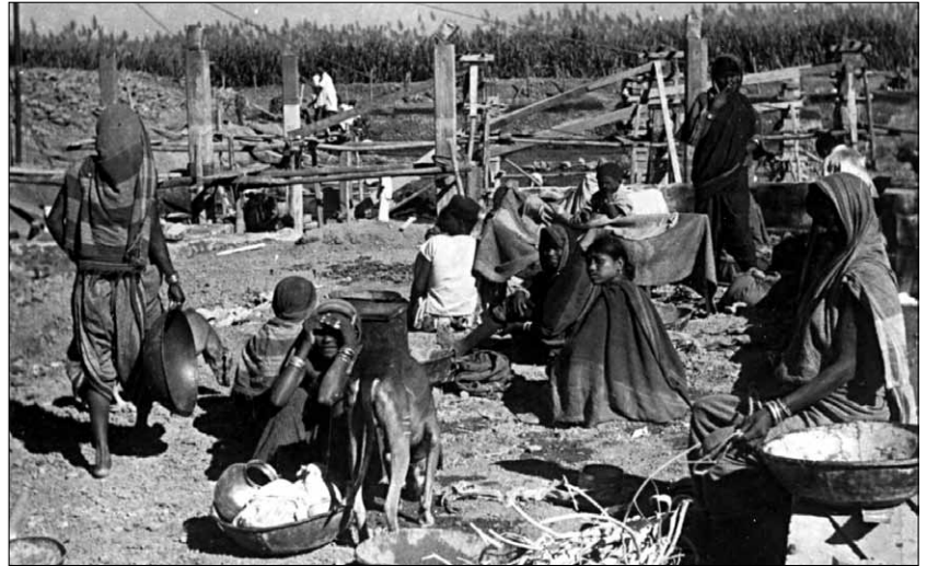
Obr. 2. Ukázka prostředí při budování cukrovarů v zemích třetího světa po 2. světové válce: zemní práce při stavbě cukrovaru Brihan – Maharashtra (foto 1951)
