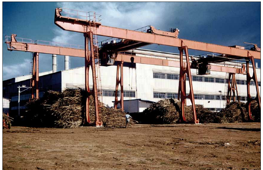
Obr. 7. Cukrovar Kantalai na Srí Lance (Cejlonu) (foto 1960)
