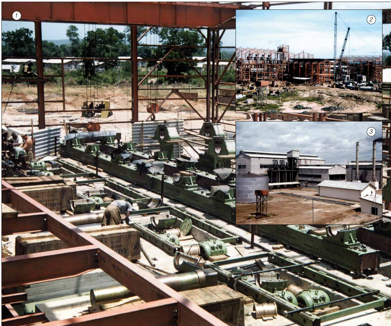
Obr. 2. Cukrovar Kantalai na Srí Lance (1959): 1 – montáž třtinové mlýnice, 2 – celkový pohled na závod v montáži, 3 – cukrovar v provozu
