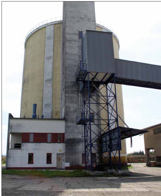
Obr. 2. Silo na 20 000 t cukru bylo postaveno v roce 1993
