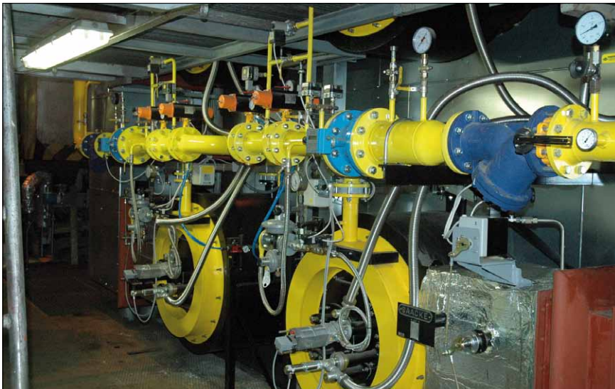
Obr. 2. Uložení čtyř plynových hořáků SAACKE DDGG-L200.3
