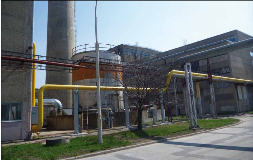
Obr. 1. Trasa přívodního STL potrubí plynu v závodu
