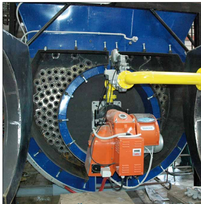
Obr. 5. Nízkoemisní plynový hořák SAACKE BGN 390-LX
