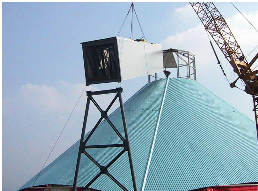
Obr. 9. Z výstavby velkého sila na 35 tis. t cukru v roce 2001 – montáž dopravního mostu
