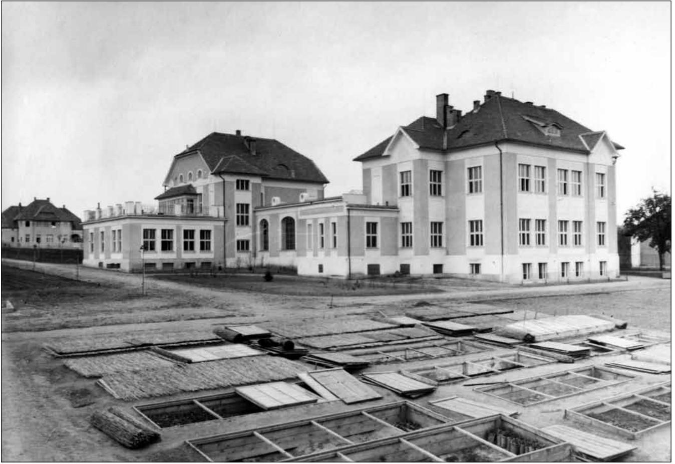
Obr. 3. Stanice pro šlechtění řepy a hospodářských plodin v Semčicích u Dobrovice
