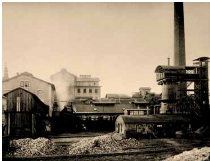
Obr. 3. Pohled na cukrovar z východu, v popředí vápenka (1915)
