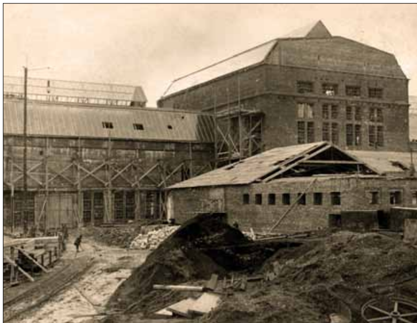
Obr. 6. Výstavba nových provozních budov cukrovaru v Českém Meziříčí (1915–1916)
