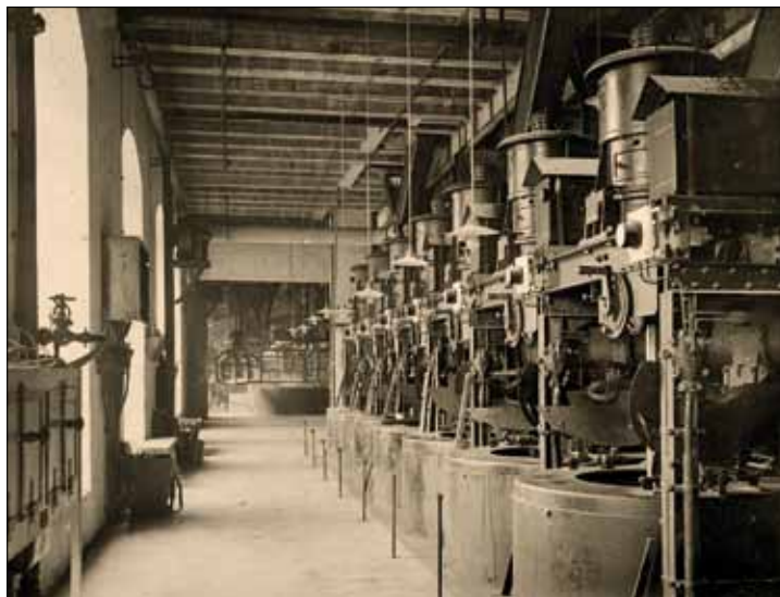
Obr. 2. Baterie odstředivek Weston ve staré rafinerii (kolem roku 1918)
