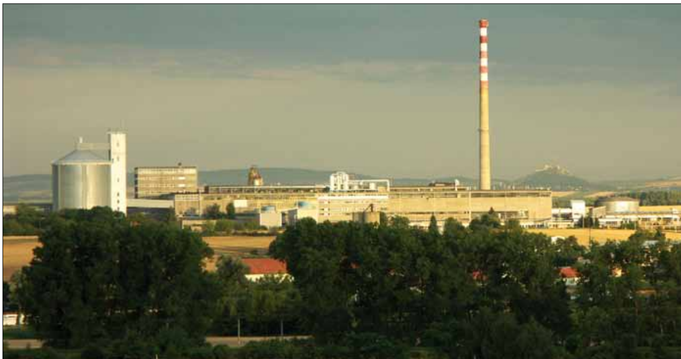
Obr. 1. Celkový pohled na areál cukrovaru v Hrušovanech nad Jevišovkou (2011)
