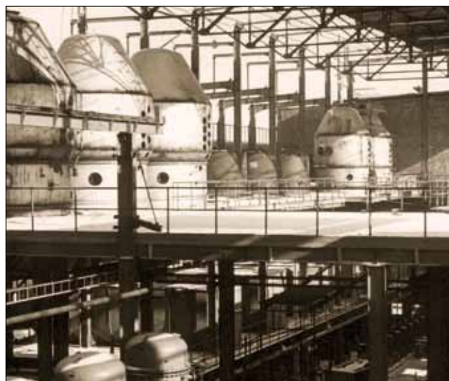
Obr. 12. Výstavba varny a změkčovací stanice šťávy
