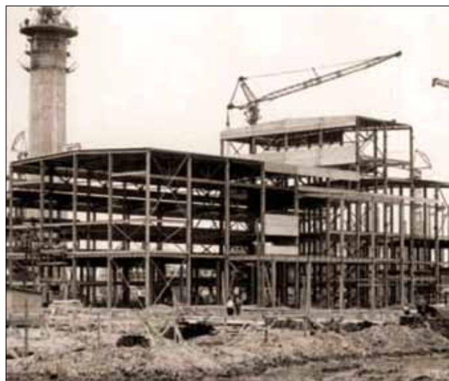
Obr. 11. Z výstavby nového závodu v Hrušovanech
