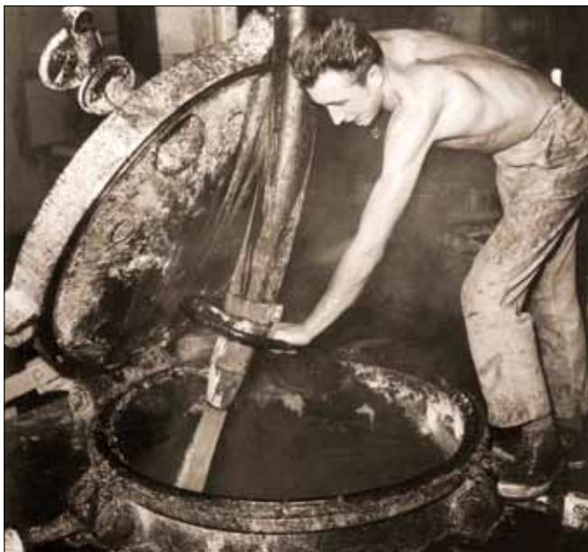
Obr. 8. Práce na Robertově difúzi – vyplachování difúzeru
