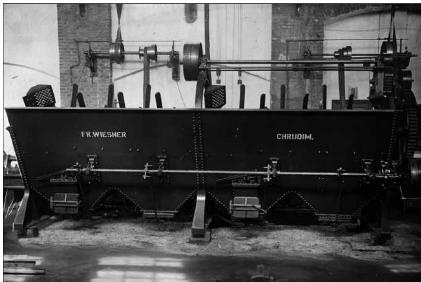
Obr. 9. Pračka na řepu, patent Karla Wiesnera, výrobek Wiesner Chrudim (SOA Zámrsk)
