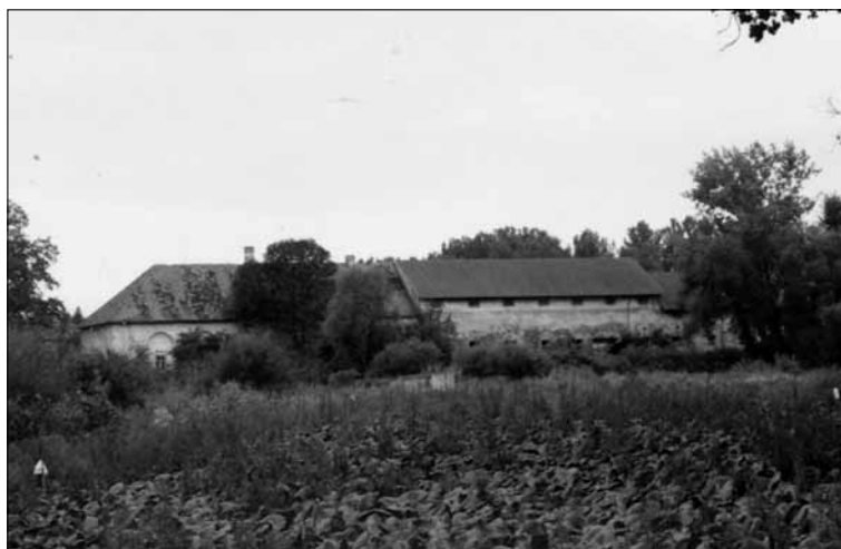
Obr. 4. Bývalý cukrovar Ledce (snímek z roku 2000)
