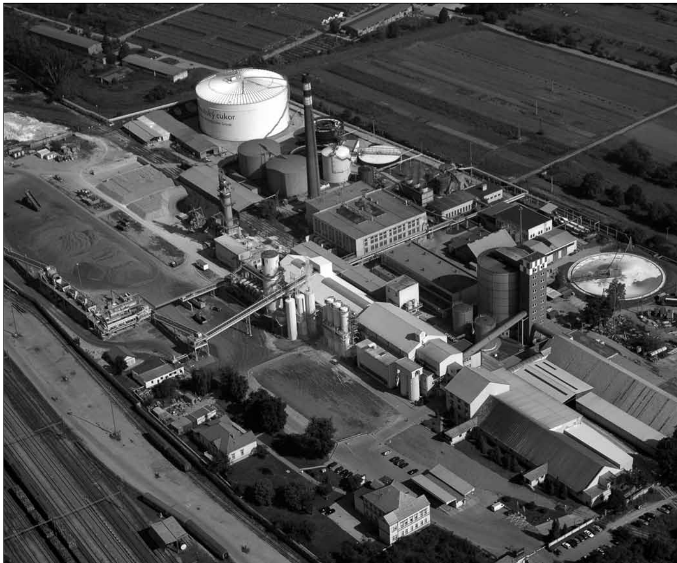
Obr. 4. Letecký pohľad na cukrovar po rekonštrukcii
