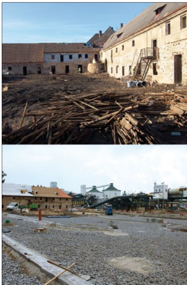
Obr. 2. Stavební úpravy v areálu budoucího muzea v Dobrovici
