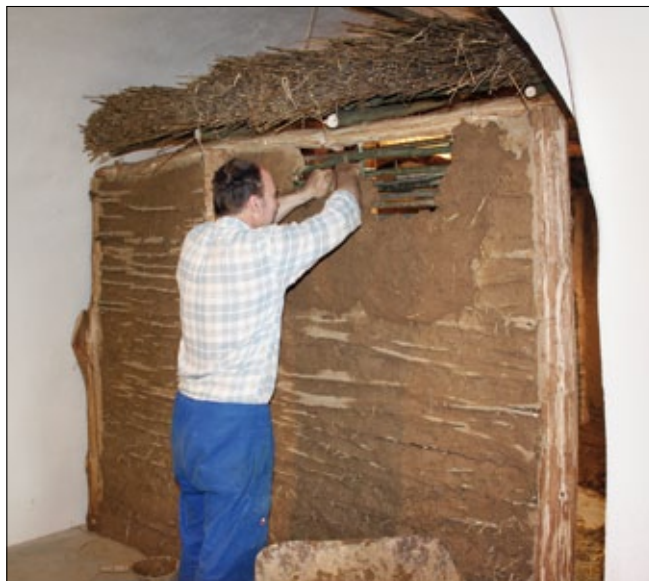
Obr. 5. Práce na stavbě chýše z doby bronzové původní technikou
