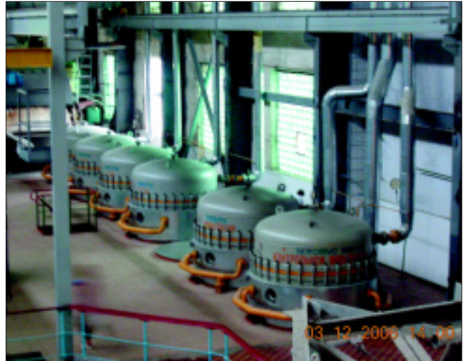
Obr. 7. Pohľad na filtračnú stanicu po rekonštrukcii (filtrácia prvej saturovanej kalnej šťavy a kontrolná filtrácia ľahkej šťavy)
