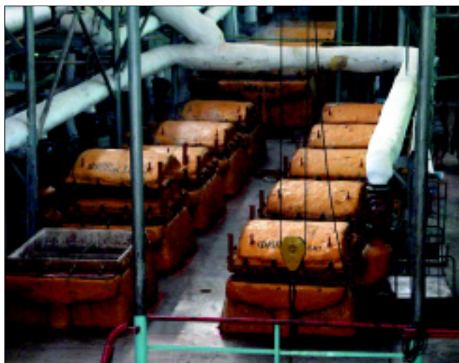
Obr. 1. Stanica filtrácie prvej saturovanej šťavy do roku 2006
