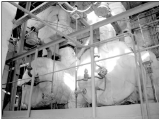
Obr. 1. Kotel s dvoustupňovým hořákem pro dva druhy paliva
